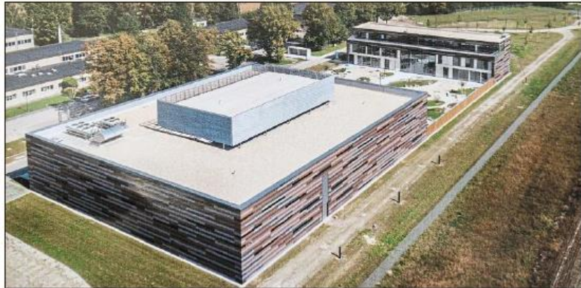
Das neue Waldwasser-Werk in Moos: Technik vorne, Verwaltung hinten.
