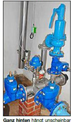
Ganz hinten hängt unscheinbar die grüne Waterbox, die für das „Internet der Dinge“ sorgt und die Daten an WBW liefert.
