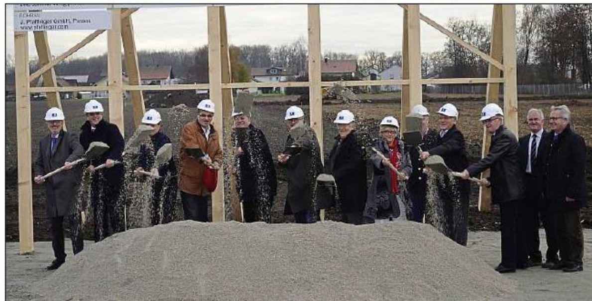
Neben dem bisherigen Standort entsteht das neue Wasserwerk in Moos. Beim Spatenstich legten neben Verbandsvorsitzendem Landrat Christian Bernreiter (5.v.l.), Werkleiter Hermann Gruber (6.v.l.) und Bürgermeister Hans Jäger (7.v.l.) auch Verbandsräte und Vertreter der beteiligten Planer und Firmen mit Hand an. – Foto: Friedberger
